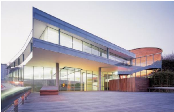
친환경 제로에너지 빌딩 그린리모델링 빌딩
